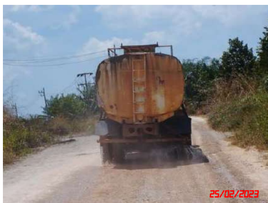
รูปที่ 23 การฉีดพรมน้ำตามเส้นทางขนแร่
